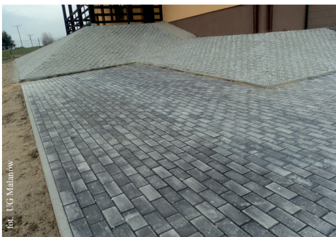
Utwardzony plac przed świetlicą w Rachowej
